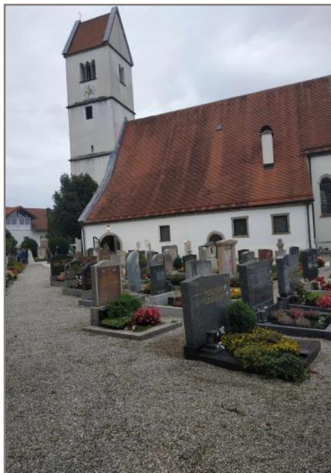
Die Friedhofswege um die Pfarrkirche St. Stephan wurden in einer Gemein- schaftsaktion von Kirchenverwaltung und freiwilligen Helfern vom Unkraut befreit.
