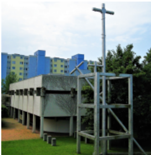
Die Jakobuskirche – 2013 wurde sie wegen schwerer Baumängel zugunsten eines neuen Kindergartens abgerissen. Das Kreuz ist geblieben. Foto: B. Kathan
