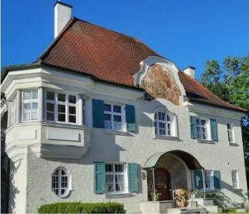
Das Pfarrhaus in Gammelsdorf ist ein zweigeschossiger Bau im Stil des barockisierenden Jugendstils, der 1912 errichtet wurde. Es zeichnet sich durch ein Walmdach, einen Schweifgiebel und einen Eckerker aus. Das Gebäude ist als villenartiger Bau konzipiert.
