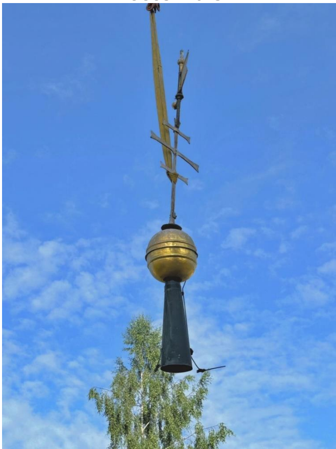
Sanierung Kirchendach Hl. Kreuz - Foto: Franz Goldhofer
