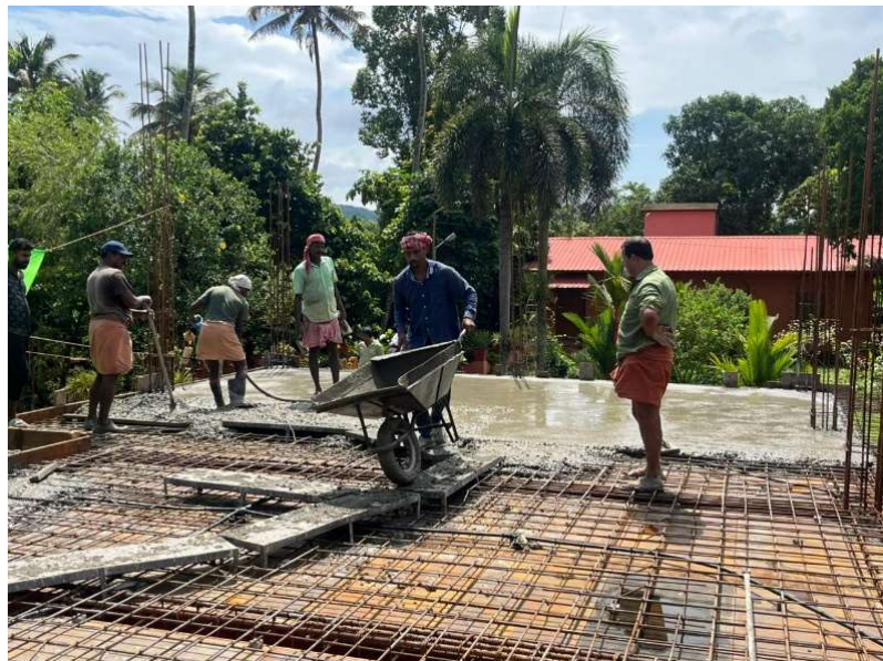
Baustelle des Administrationsgebäudes
