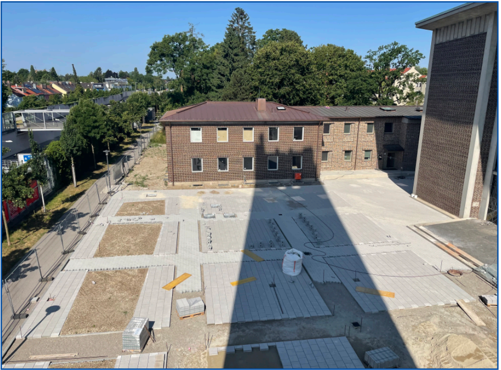
Blick vom Turm auf das Pfarrheim. In die ausgesparten Flächen links werden Bäume gepflanzt.
