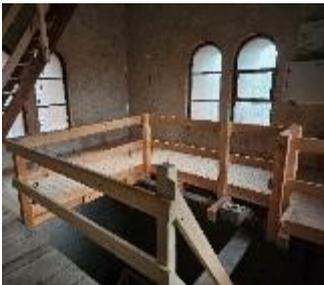
2020 beschloss die Kirchenverwaltung den Einbau einer neuen Plattform auf der Höhe der Doppelfensteretage. Hierzu sollten alle historischen Auflagerpunkte verwendet und durch eine zusätzliche Querkonstruktion erweitert werden. Der innere Freiraum wurde durch ein solides Geländer abgesichert.
