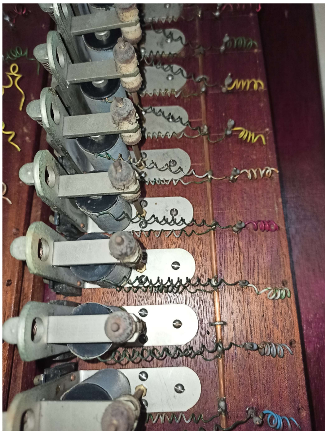
Die über 60 Jahre alten Magnet-Relais (links) werden durch eine moderne Elektrik (rechts) ersetzt
