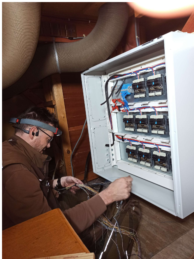
Die über 60 Jahre alten Magnet-Relais (links) werden durch eine moderne Elektrik (rechts) ersetzt
