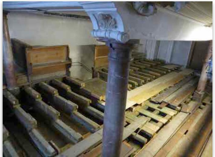
**Foto: Für den Statiker geöffneter Boden auf der ersten Empore**
